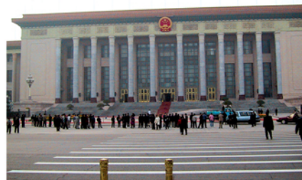
人民大会堂工程
