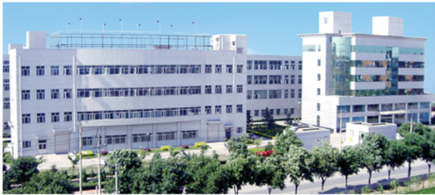
总装 A 厂区全景图
