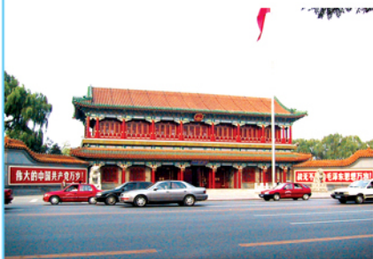
中南海变配电工程
