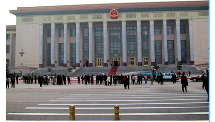
人民大会堂工程
