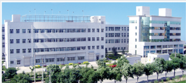
总装 A 厂区全景图
