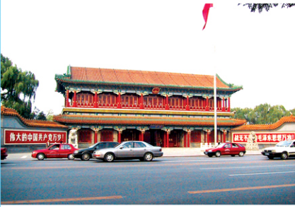
中南海变配电工程
