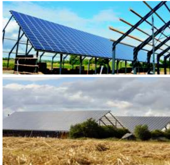
200kW, 丹麦光伏农场
