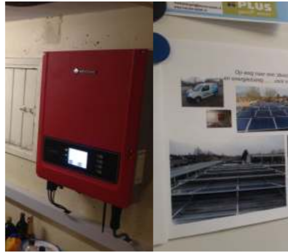
70kW, 荷兰学校项目
