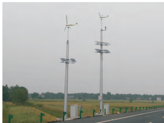
风光互补监控系统 wind-solar monitor
