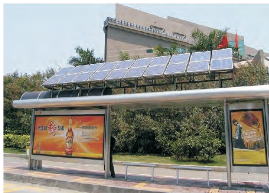
太阳能候车亭 solar bus shelter
