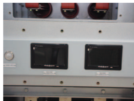
图9 通过屏幕可明显见到隔离开关分合状态
