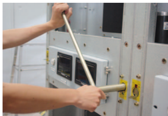
图5 隔离开关由合位到分位逆时针旋转操作
