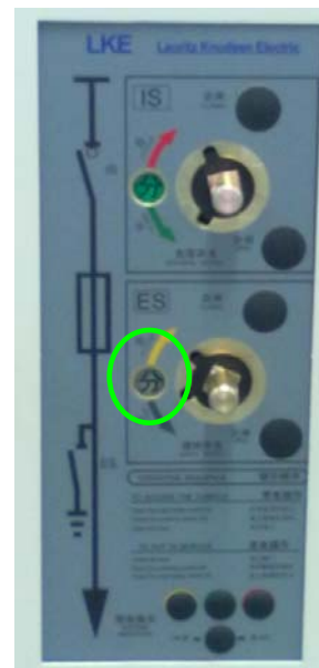
图 16 分接地开关后的状态指示
