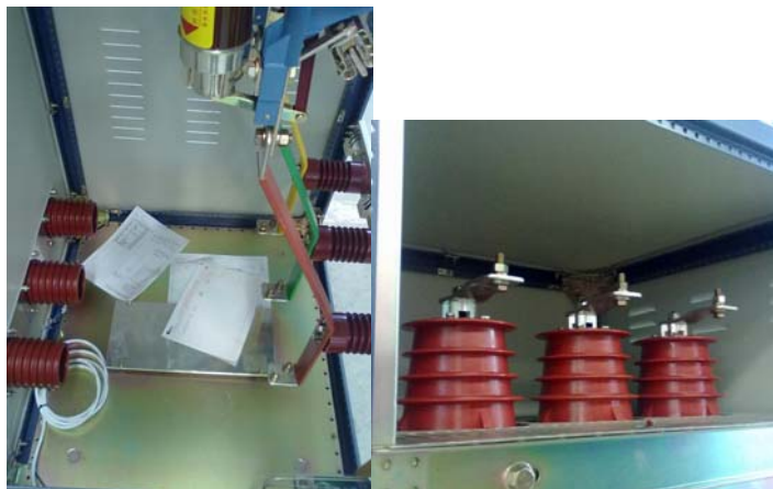
图 10 重点检查电缆室和主母线室
